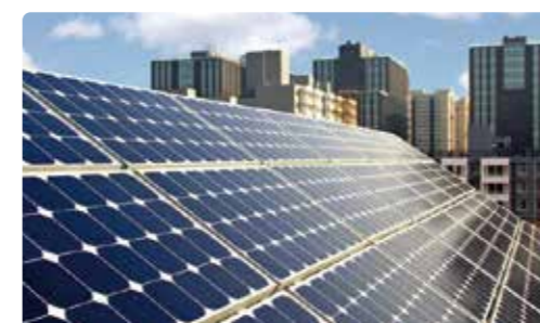
无人值守光伏电站
